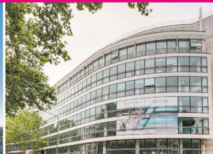
Inspira - Issy-les-Moulineaux 10 500 m 2 de bureaux et services rénovés
